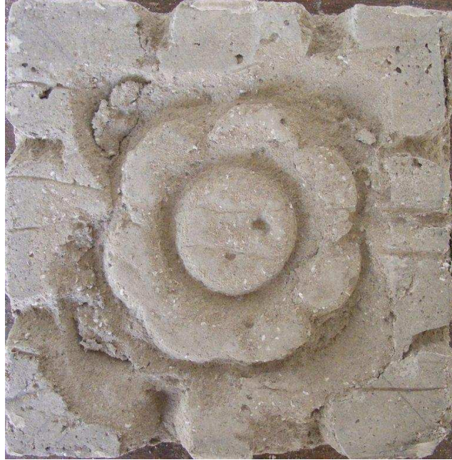
Gb. 61. Skala Campuran 1:2:1:1. Teknik Ukir Mudah patah
